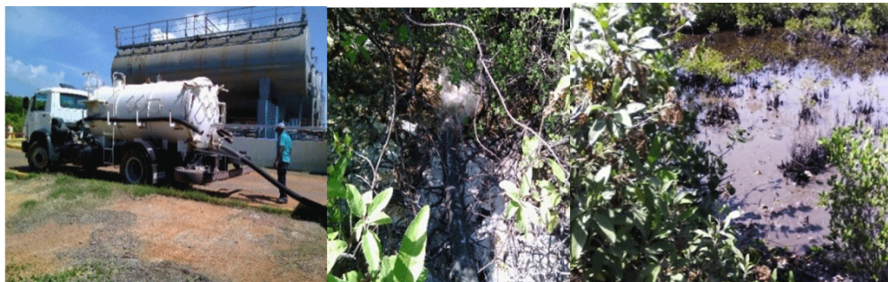
Figura 3. Proceso de carga en PTR e inoculación del lodo en el área afectada
