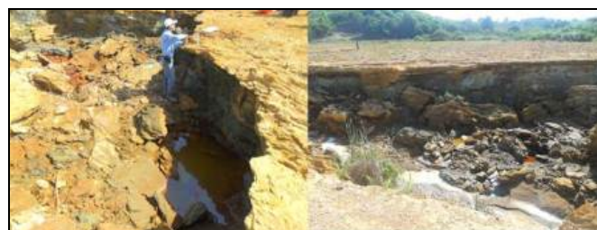
Fig.1. Dos vistas de la presa de colas del Yacimiento Júcaro donde se aprecian la cárcava formada por la escorrentía superficial del agua y los procesos de erosión.
